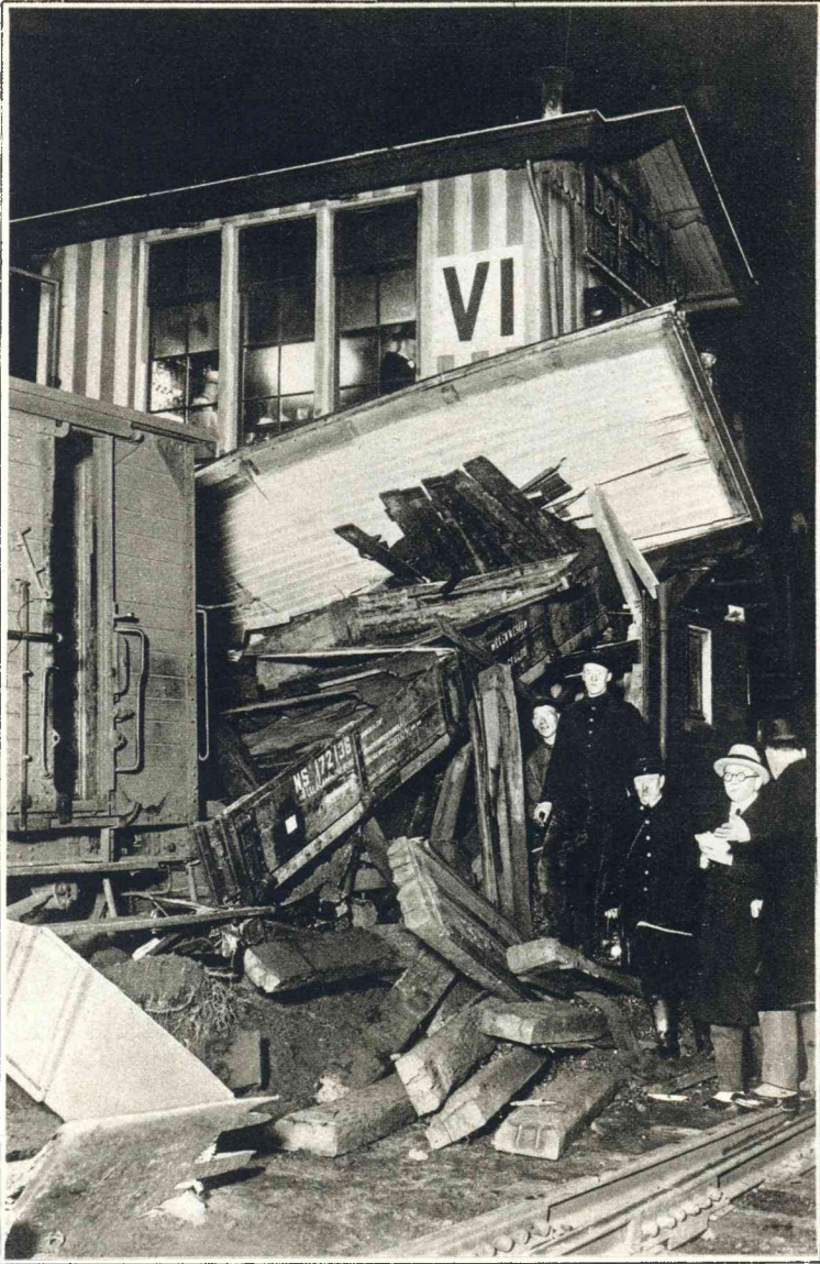
OP HET MUIDERPOORT EMBLACEMENT te Amsterdam liep een trein door onveilig signaal op een stootblok; het stootblok en een brandstoffenloods werden vernield en een seinhuisje zwaar beschadigd.
