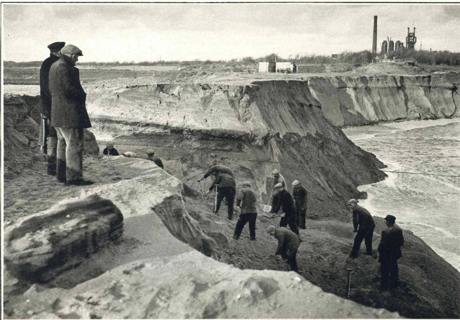
DE LAATSTE DAM. Dinsdagmiddag is de laatste afsluitdam bij de nieuwe sluis te IJmuiden doorgegraven. Men ziet op deze foto de werklieden bezig met het graven van de opening, waardoor met den vloed het water binnenstroomde.
