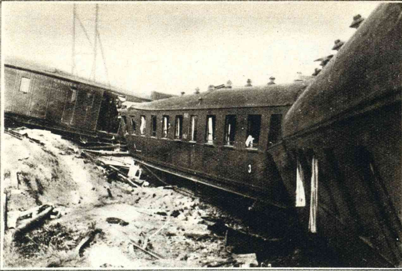
DE D-TREIN Parijs-Warschau verongelukte, door te groote snelheid op een in reparatie zijnd baanvak, tusschen Düren en Keulen. Deze foto toont hoe enkele wagons buiten de rails werden geplaatst.
