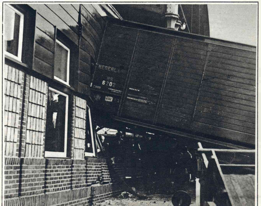
TE ROTTERDAM liep op het station D. P. een ledige goederen- wagen tegen het posthuisje op 't perron, dat ernstig beschadigd werd.
