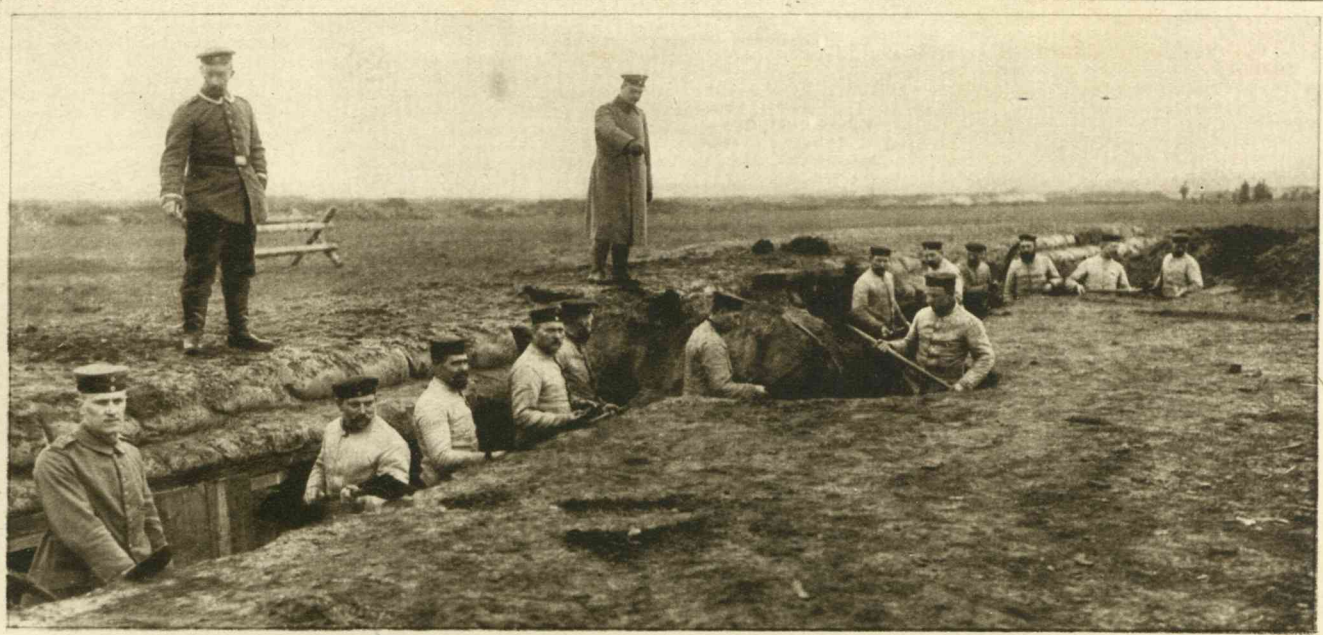
RESERVE-LOOPGRAVEN. Duitsche soldaten zijn bezig met het vervaardigen van reserve-loopgraven. Om instortingen te voorkomen, worden de wanden met balken en planken gestut. Eigenaardig is de onregelmatige lijn van de loopgraaf.
