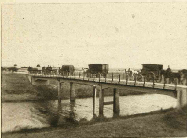
De bagagetrein eener pontonafdeeling.
