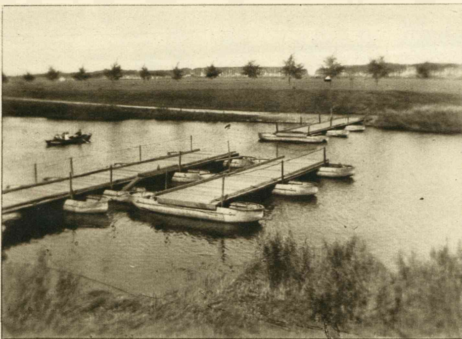
Een pontonbrug met een doorlaat.
