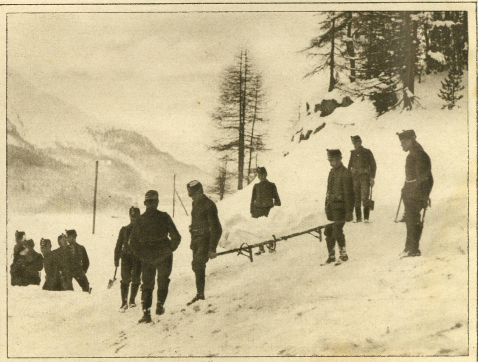
Loopgraven welke in de sneeuw worden uitgediept en met sneeuw versterkt.
