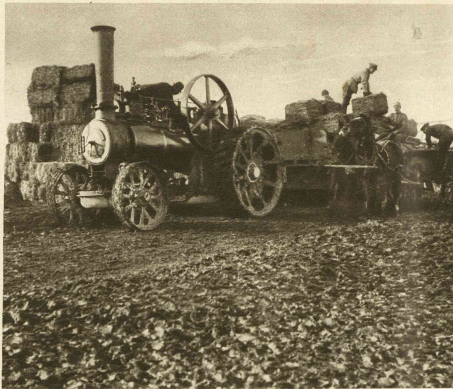
Naar de plaatsen die per spoor niet te bereiken zijn, geschiedt het vervoer van fourage enz. met locomobielen.
