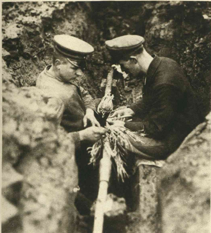
HET HERSTELLEN VAN EEN TELEGRAAFKABEL. In het verwoeste België probeeren de Duitschers het leven nu weer zooveel mogelijk tot het normale terug te brengen, vandaar dat alles zoo spoedig mogelijk hersteld wordt.
