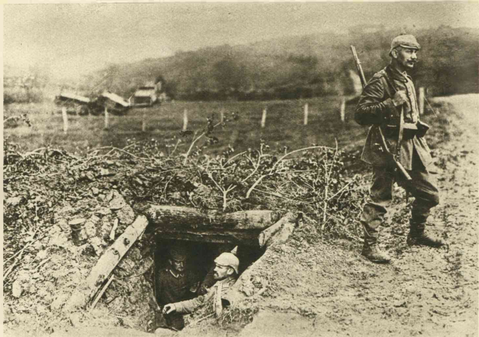
DE ONDERGRONDSCH E GANGEN. Dagen achtereën zijn de troepen dikwijls genoodzaakt in de door hen gegraven loopgraven te verblijven. In vele gevallen hebben de loopgraven ondergrondse verbindingen met elkander, zooals wij er hierboven een in beeld brengen.
