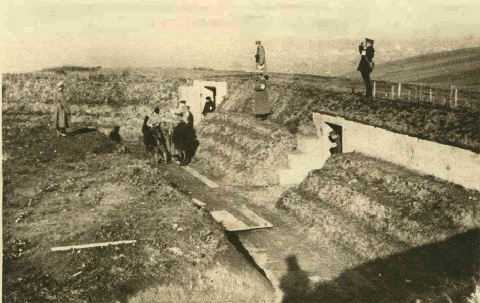
EEN OOSTENRIJSCH VERSTERKING, door dezen verlaten en door Russische soldaten bezet. Ook hier is met groote zorg het werk aan de verschansingen verricht.
