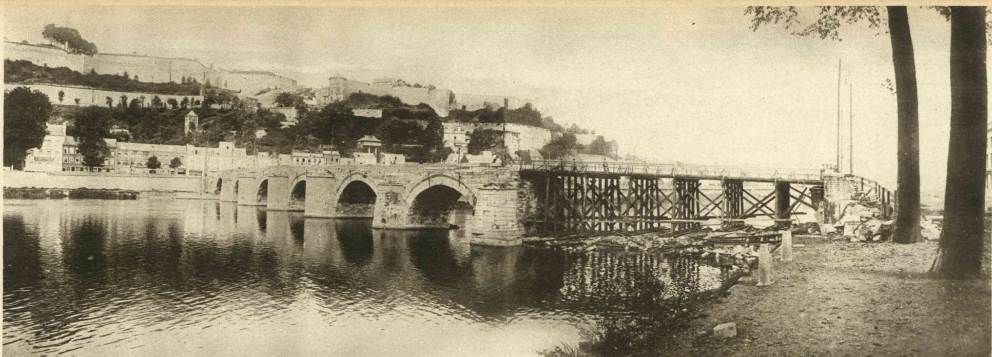
HET HERSTELLINGSWERK. De Duitsche genie-soldaten gaan met ijver voort om de in Oost-België ontstane beschadiging aan wegen en bruggen te herstellen. Hierboven de door de Belgen opgeblazen Pont de Jambes, over de Maas bij Namen, zooals deze thans is.
