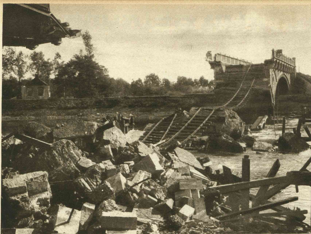
DE BRUG OVER DE NETHE BIJ DUFFEL, welke door de Belgen opgeblazen werd om het verder trekken der Duitsche troepen tegen te gaan.
