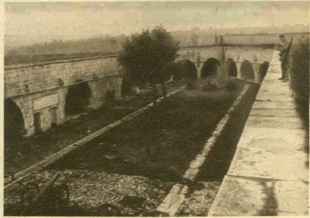
Het fort te Dinant inwendig gezien. In de duidelijk zichtbare gewelven bevinden zich de vuurmonden.
