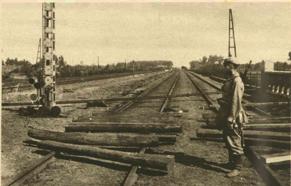
LANGS DE SPOORBAAN.
