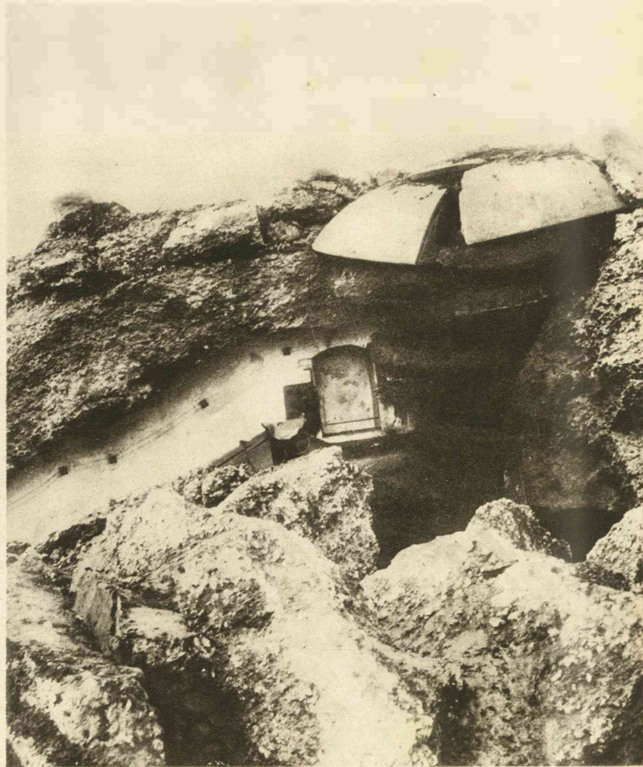
DE UITWERKING VAN HET MODERNE GESCHUT. Een koepelfort van beton door het Duitsche 42 cM. belegeringsgeschut totaal stuk- geschoten. (foto's Ver. Fotobureaux)
