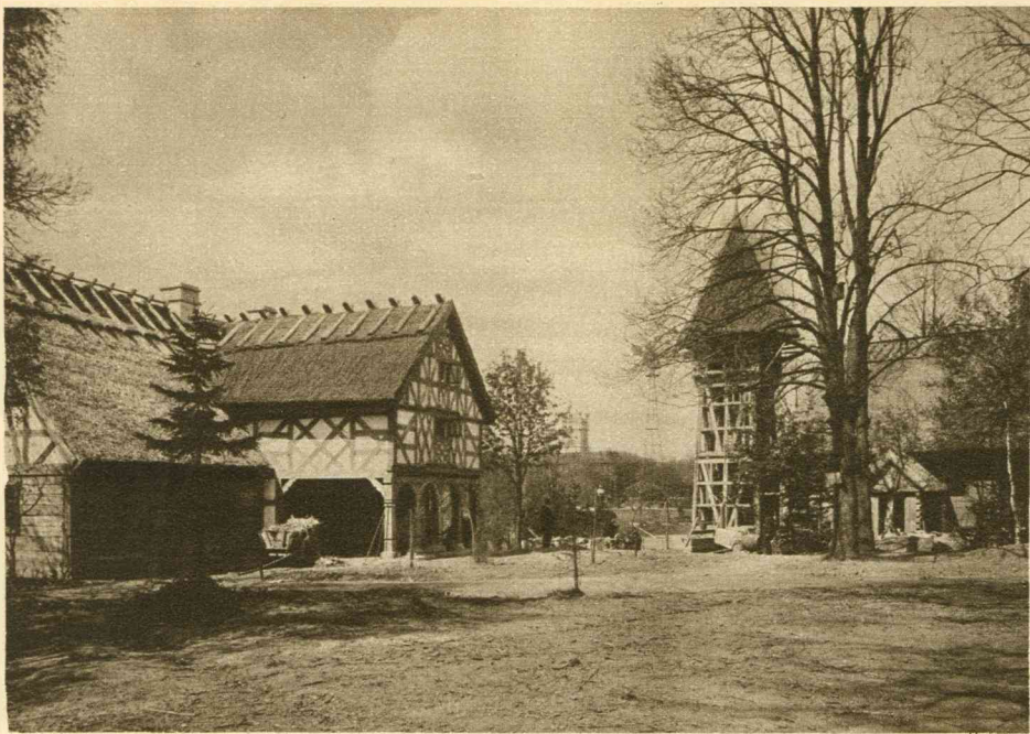
Het Openluchtmuseum te Königsberg in aanbouw. (Op den achtergrond zijn de gebouwen van den dierentuin).
