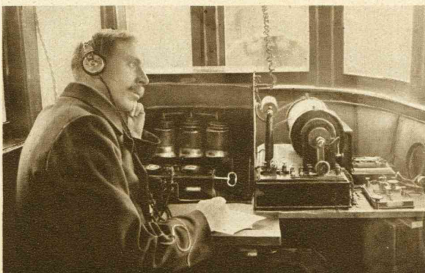
Het opnemen van een dienstorder aan boord van de elektrische boot
