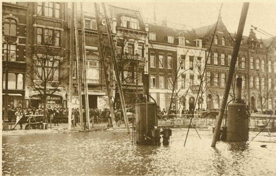
De Coolsingel ondergelopen! — Nauwelijks hebben de uitvoerders van het werk aan den Coolsingel zich verheugd in het droogleggen van een groot gedeelte, of een soort catastrofe is een streep door de rekening komen halen: het drooggemalen gedeelte is weer geheel volgelopen, ter hoogte waar de afsluitdam geslagen is. Het water uit het gevulde gedeelte is, onder de tramrails door en om den dam heen, in het drooggelegde stuk gestroomd.
