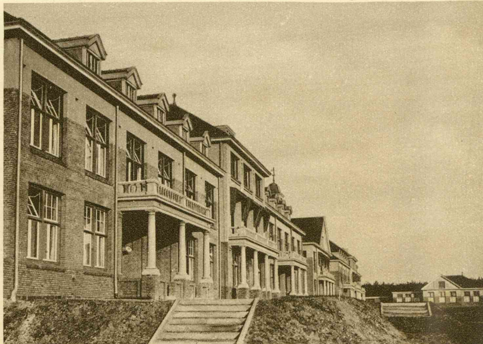
VOORZIJD VAN HET HOOFDGEBOUW, dat een lengte heeft van 180 Meter. Aan de voorzijde bevindt zich een groot ravijn, dat met dennen begroeid is.
