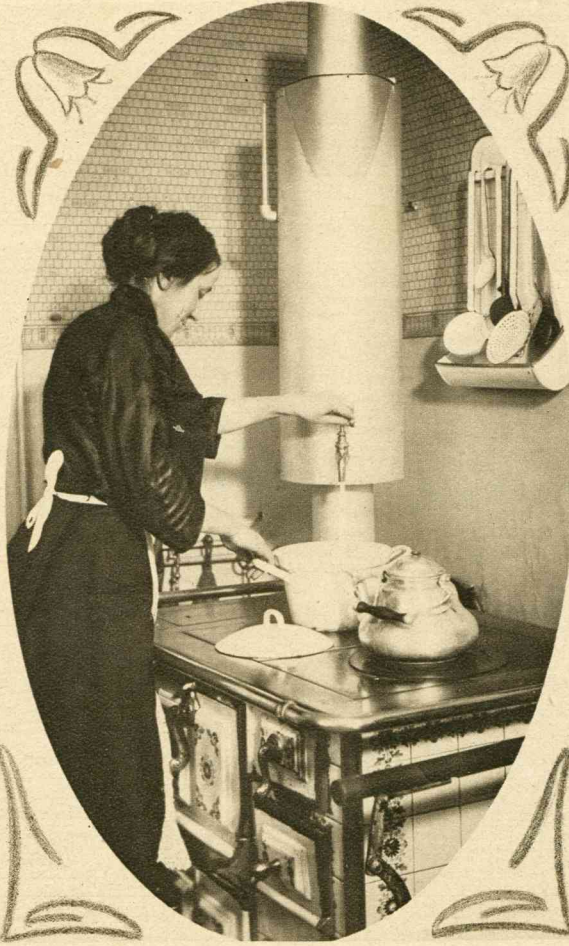
DE NIEUWSTE METHODE om steeds warm water in huis te hebben. - Zooals men ziet, wordt om de pijp van het fornuis een reservoir aangebracht, waarin natuurlijk in een minimum van tijd het water verwarmd is.
