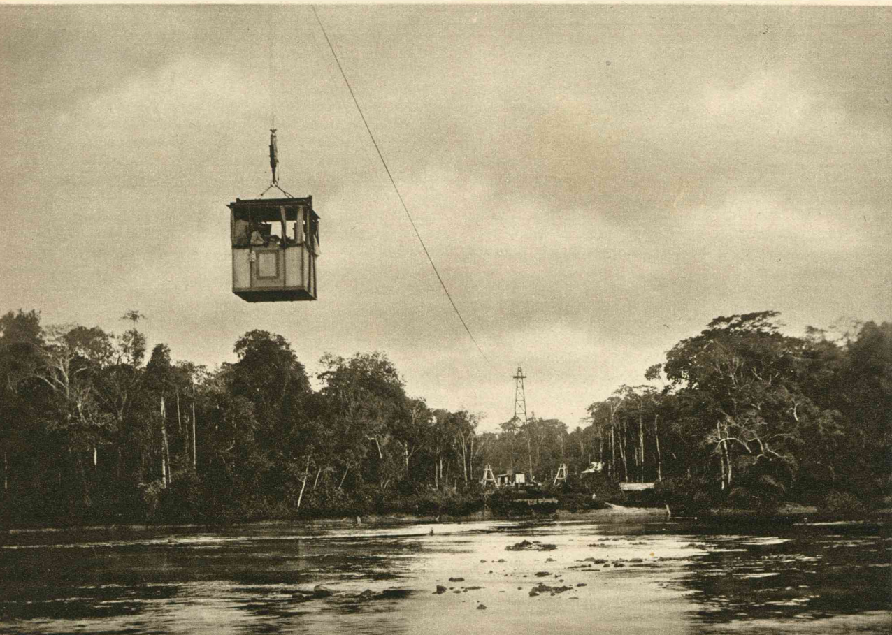
KABELSTATION. - HET OVERBRENGEN VAN EEN KOOI PASSAGIERS.
