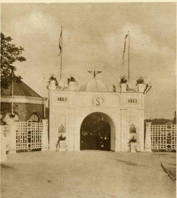
EEREPOORT VOOR DE CENTRALE WERKPLAATS TE ZWOLLE.
