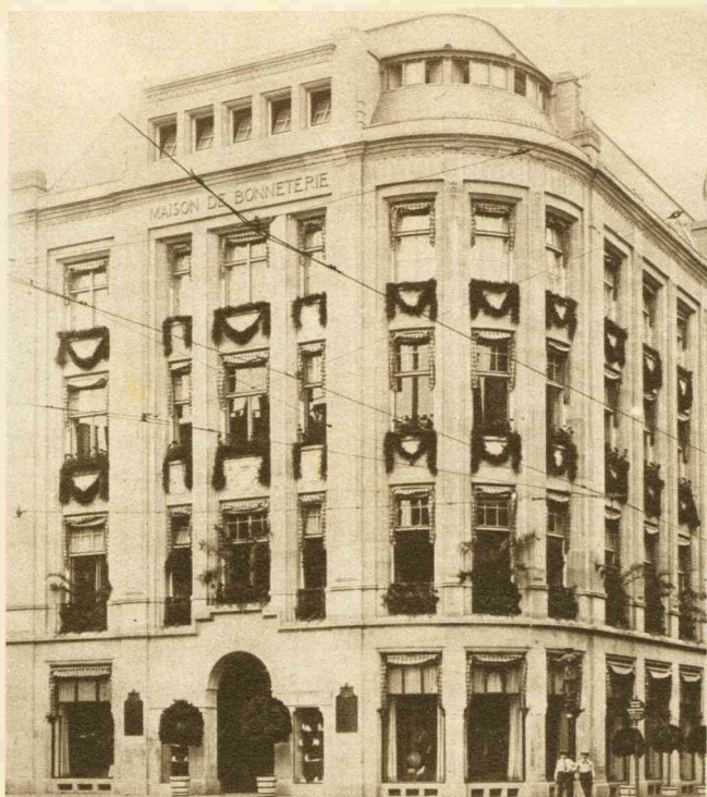
MAISON DE BONNETTERIE TE 'S-GRAVENHAGE IN FEESTDOS.
